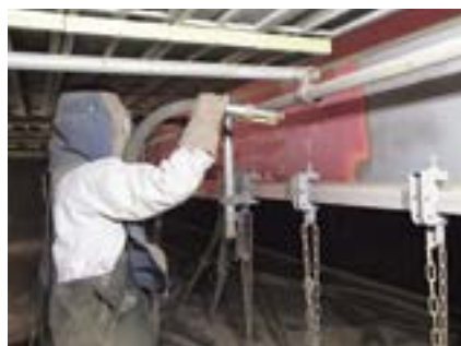
同社が得意とするサンドブラスト施工。塗装前の下処理を効果的に行うために、高圧空気です砂を打ち付け、古い塗膜をはがしている。
