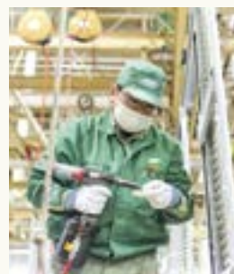
運搬中の荷物が揺れないように、トラック内の側面に金物を取り付ける作業の様子。
