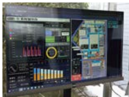
本社玄関にCO 2 排出量モニターを設置。工場内の電気・ガスの使用量を見える化することで、目標とするCO 2 削減への意識付けに繋がっている。
