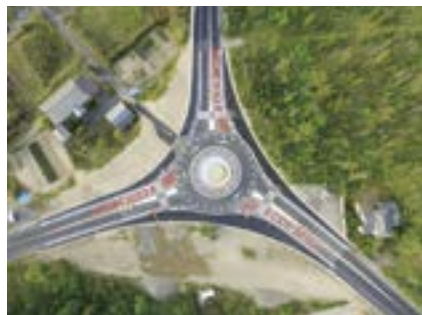
西蒲区角田浜三叉路にある、新潟市初の環状交差点（ラウンドアバウト）を設計。信号機がないので停電時でも機能不全に陥らない。
