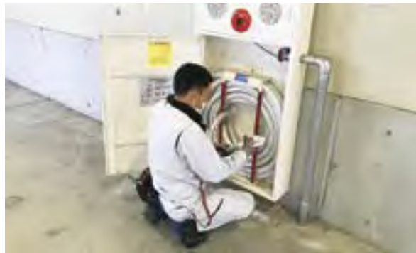
施設内にある消火用散水栓を点検。消防設備点検は消防法を熟知した国家資格者が担当。同社は消防設備士、電気工事士など、業務に必要な技術資格の取得に向けた社員教育制度も充実している。
