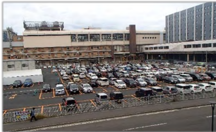
写真 本事業用地の利用状況（駐車場）
